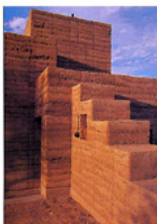
Dem traditionellen Adobe entlehnt, ließ der Architekt die einzelnen Lehmsschichten der Fassade unverputzt
